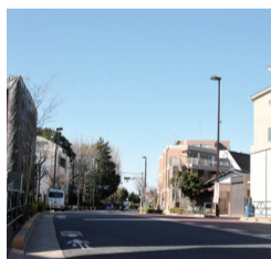
無電柱化を実施した街並み
