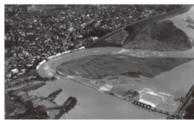
(昭和49年 多摩川堤防決壊の様子)
