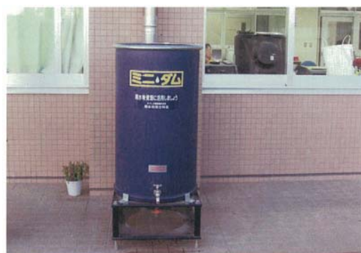
図-12.4 雨水貯留施設 (タンク)
