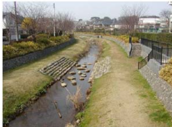
図-12.2 野川改修後の様子 (小金井市)
