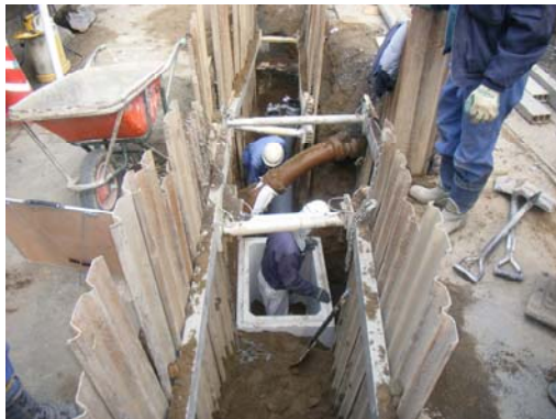
図-10.1 雨水管渠の施工状況
