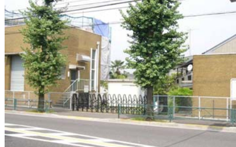
図-1.3 中継ポンプ場（東和泉 1 丁目）
