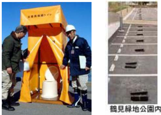
図-17.2 マンホールトイレシステムの例 出典：地震対策マニュアル 2006
