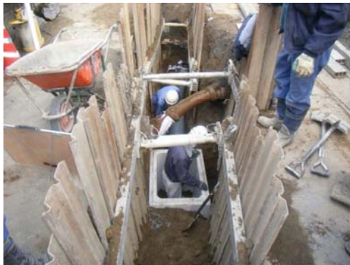
図-11.1 雨水管渠の施工状況
