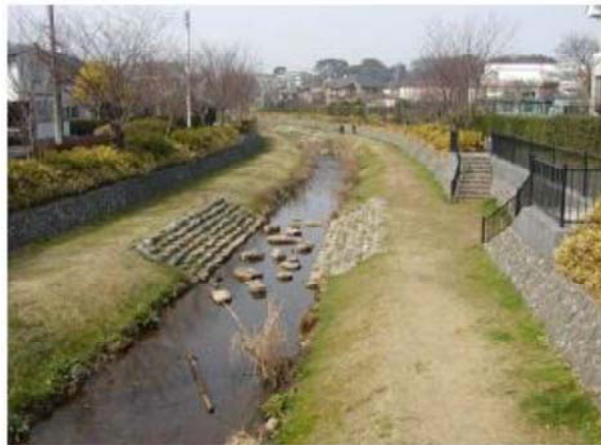
図-14.2 野川改修後の様子（小金井市）
