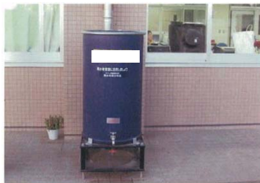
図-14.4 雨水貯留施設（タンク）
