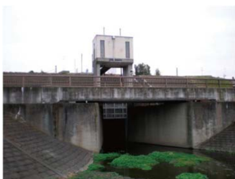
図-1.1 分流雨水放流渠 きよ (猪方排水樋門・駒井町3丁目)
