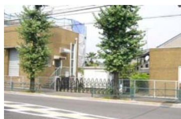
図-1.3 中継ポンプ場（東和泉1丁目）
