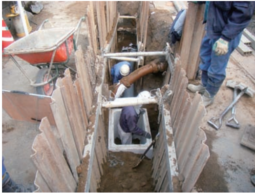
図-11.1 雨水管渠の施工状況
