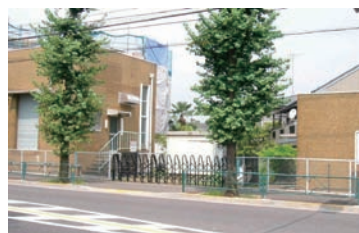
図－1.3 狛江（中継）ポンプ場（東和泉1丁目）
