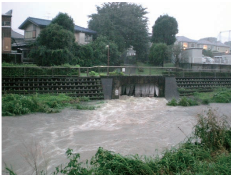
図-12 越流水放流状況（No. 1 吐口・平成 21 年 8 月 7 日撮影）
