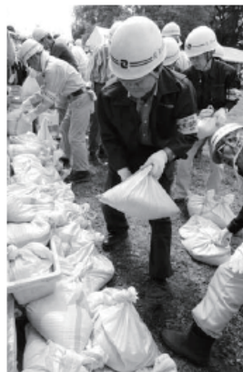
▲土のうを積んで建物内への浸水を防ぎます
