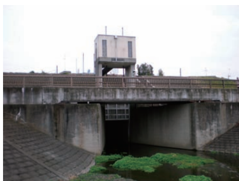
図－1.1 分流雨水放流渠 きよ （猪方排水樋管・駒井町3丁目）
