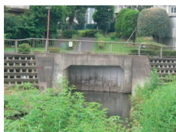
図－1.2 越流水放流渠 きよ （世田谷区）
