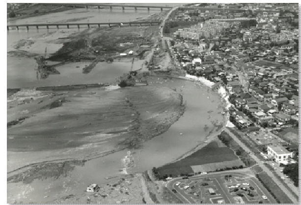
濁流により挟まれた猪方地先(上空から)
