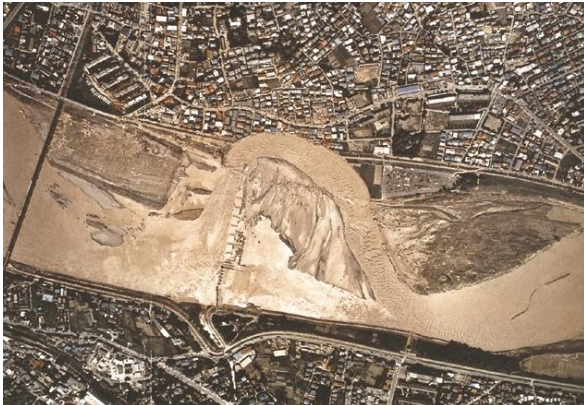
台風 16 号(昭和 49(1974)年)による被害
