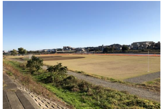
多摩川緑地公園グラウンド(復旧後)
