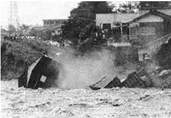
台風 16 号(昭和 49(1974)年)による被害
