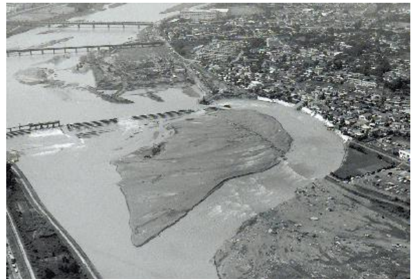
台風 16 号(昭和 49(1974)年)による被害
