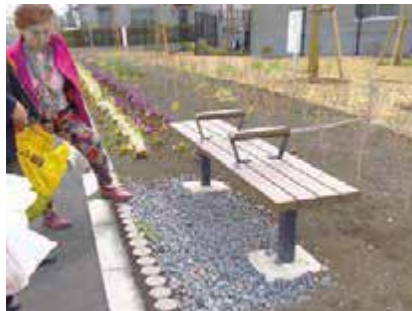
完成後の道路を歩く。狛江高校前、ベンチ設置の足元に段差があるのは危険では？と報告しフラットなつくりに変更された。
