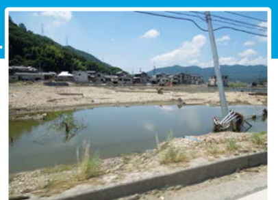
水害後の岡山県倉敷市真備地区
