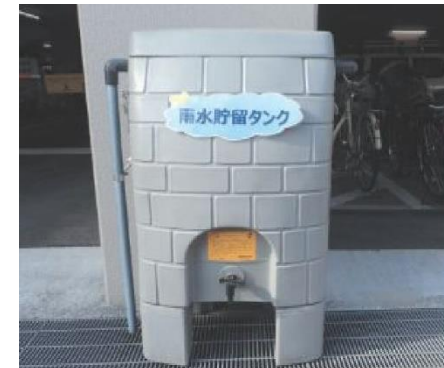
雨水貯留タンク
