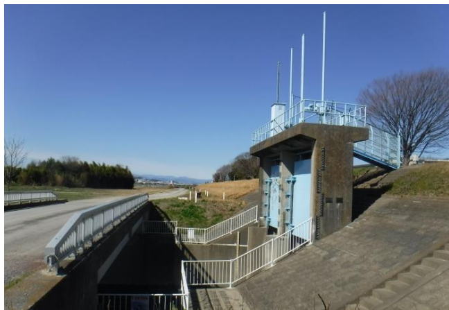
調布排水樋管
