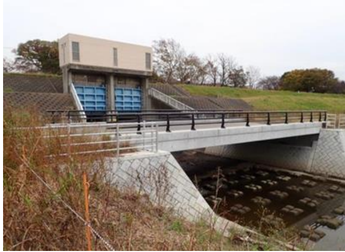
六郷排水樋管
