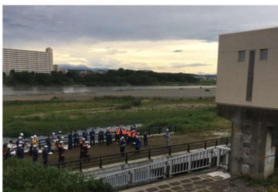
六郷排水樋管
