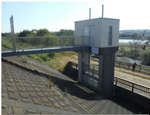
写真 1 猪方排水樋管
