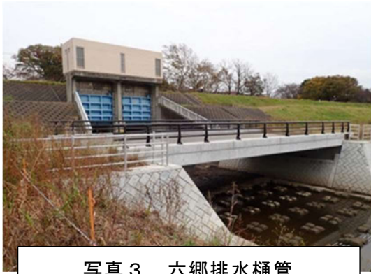
写真3 六郷排水樋管
