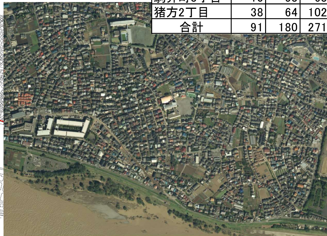
国土地理院空中写真（正射画像）10/13撮影 猪方排水樋管周辺
