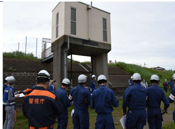
猪方排水樋管
