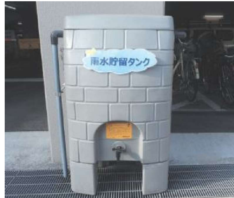
雨水貯留タンク
