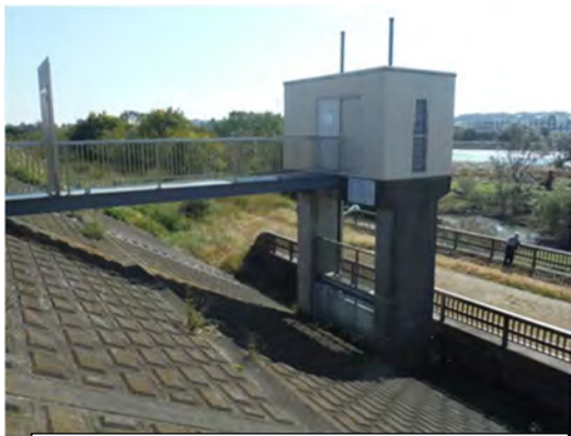
写真 1 猪方排水樋管
