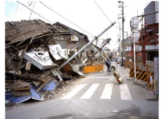
阪神・淡路大震災で倒壊した電柱
