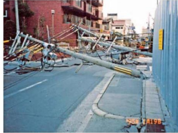
阪神・淡路大震災で倒壊した電柱
