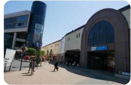
狛江駅北口の駅と直結した再開発ビル
