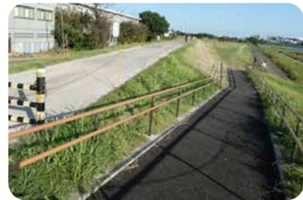
近年、堤防天端の舗装工事を 実施した区間(猪方付近)
