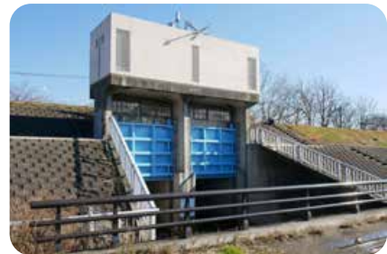
六郷排水樋管
