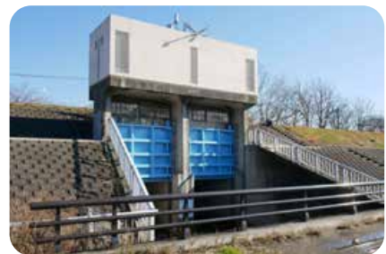
六郷排水樋管
