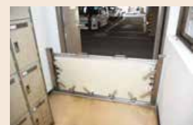
止水板の設置例
