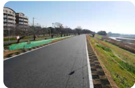
近年、堤防天端の舗装工事を 実施した区間(西和泉付近)
