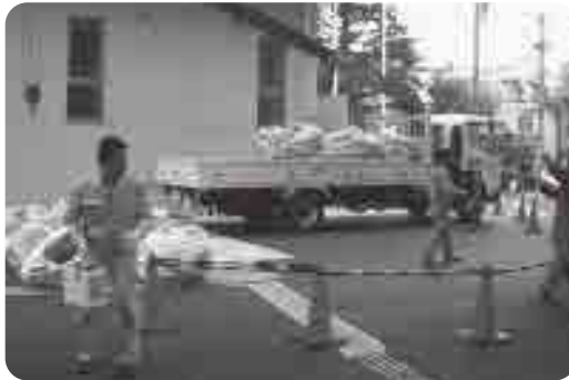
～トラックへの積み込み～
