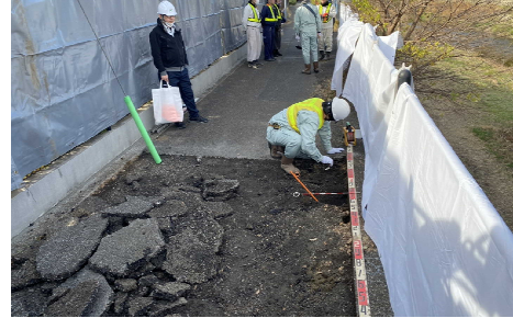
路盤等の確認状況
