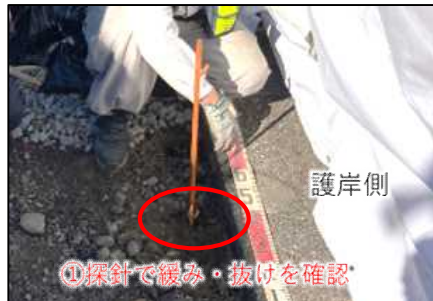
探針の状況 (野川サイクリング道路上より)
