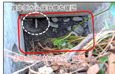
探針の状況 (護岸の緑化ブロック側より)
